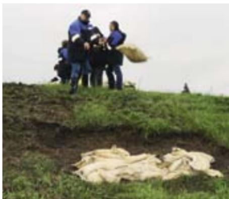
Ausschlagungen an der Böschung, z. B. durch treibende Gegenstände, werden durch Sandsäcke verfüllt.
