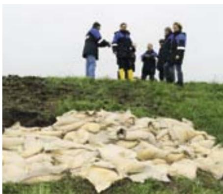
Bei ansteigendem Wasserstand werden die Sandsäcke von der Deichkrone in die Ausschlagung geworfen, bis die Schadstelle und die Randbereiche vollständig verfüllt sind.
