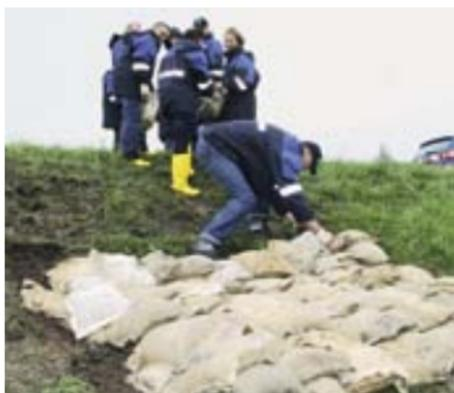
Zur Sicherung einer Ausschlagung nach einer Sturmflut werden die Sandsäcke im Bereich der Schadstelle geordnet eingebaut.
